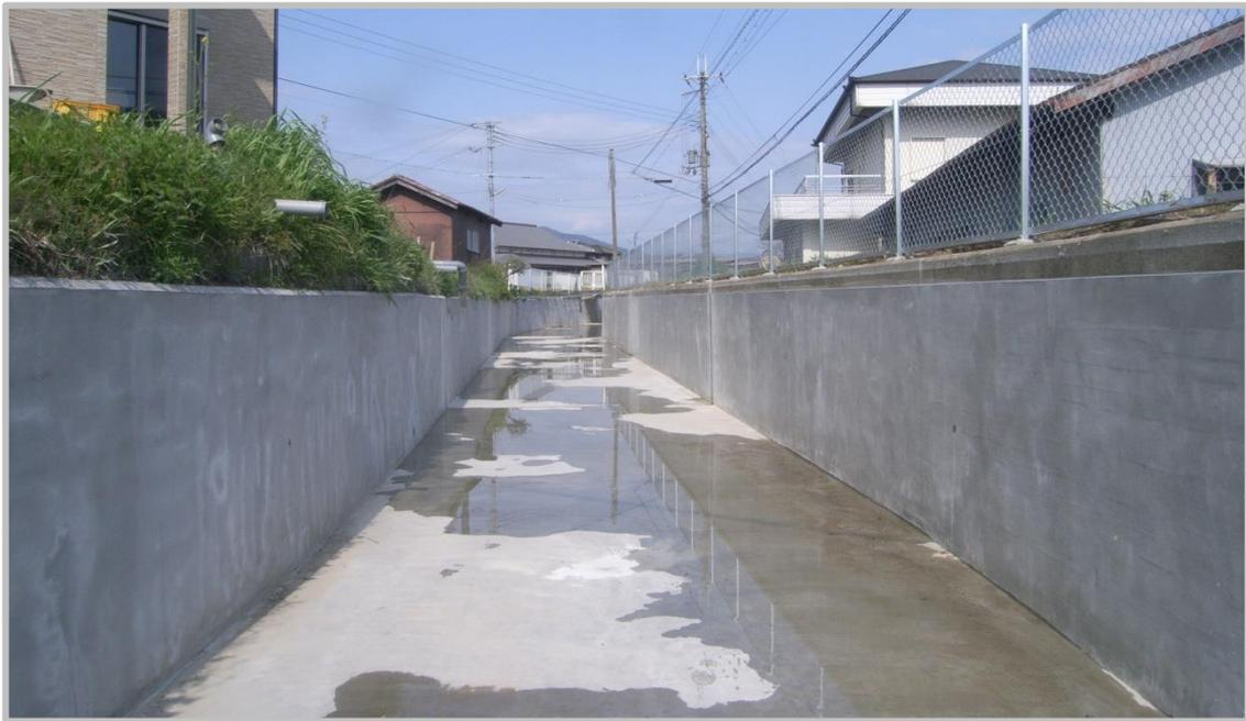
ASモルタル工法は、高炉スラグ系再乳化型粉末アクリルポリマーセメントモルタル『ASモルタル』を用い、劣化構造物の表面保護を行うことで、構造物の機能を回復させる工法です。優れた接着性で既存構造物と一体化し、耐摩耗性や水密性に優れコンクリート構造物を劣化要因から守ります。
