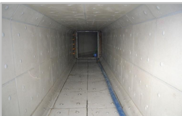
下水処理施設補修
