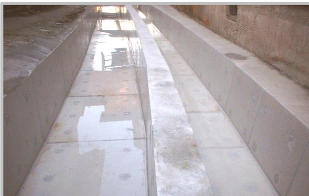
農業水利施設補修
