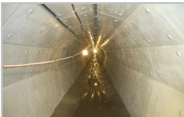
導水路トンネル補強
