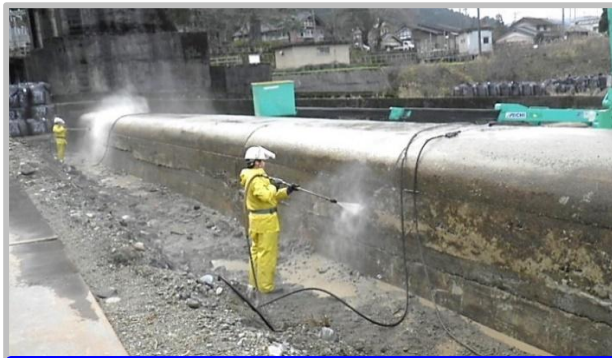
① 下地処理工(高圧洗浄)
