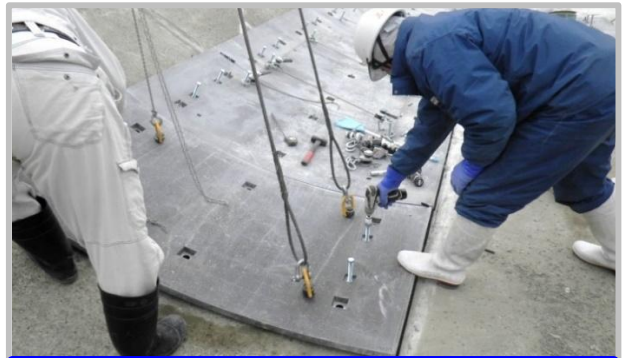
② パネル設置工(高さ調整)
