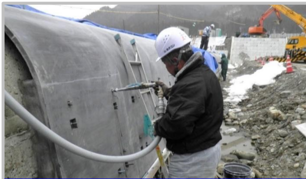
⑤ 無収縮グラウト充填工
