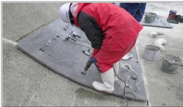
③ アンカー工
