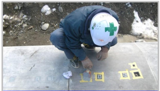
⑥ 仕上げ工(充填材充填)
