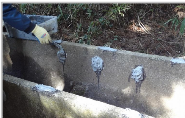
③ プライマー・接着剤塗布工
