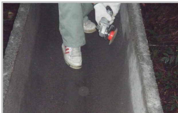
② 下地処理工(ケレン・高圧洗浄)
