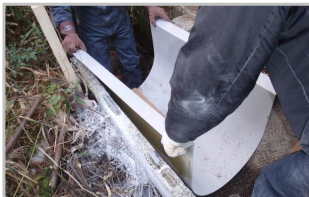
④ FRPフリュームカバー設置工
