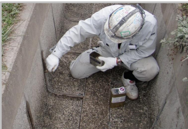
③ プライマー塗布工
