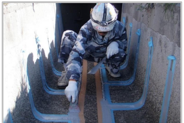
④ シーリング材充填工
