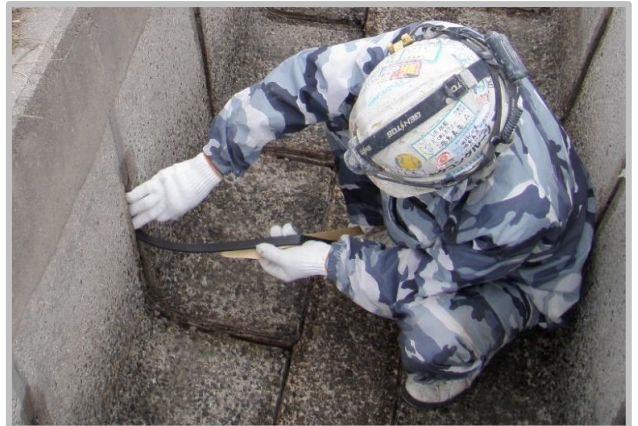
② バックアップ材装填工
