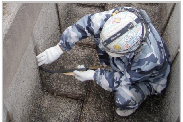
② バックアップ材装填工
