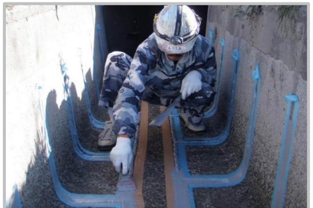
④ シーリング材充填工
