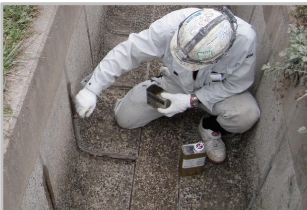
③ プライマー塗布工
