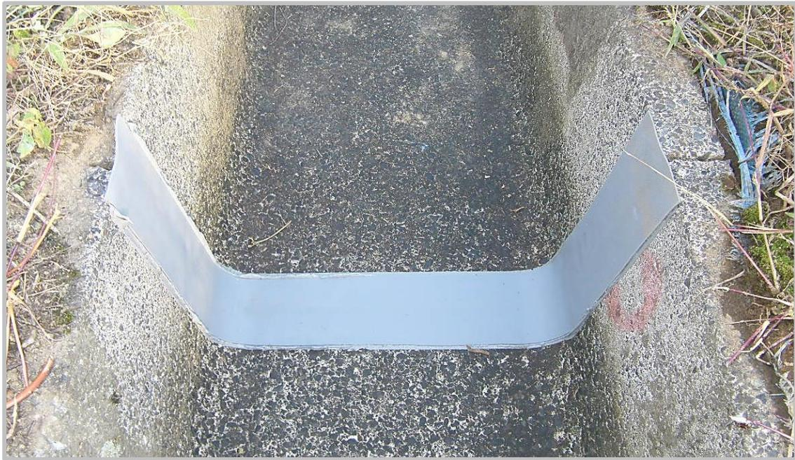
『Hyperシンプルシート』は優れた防水性能を有したシリコーン製の特殊粘着シートです。伸縮性に優れており、コンクリートの挙動に追従し、長期止水が可能です。耐候性・耐熱性・耐寒性にも優れているので様々な施工環境化においても安定した品質を確保できます。また、施工が容易で、誰でも簡単に取扱いできるのが特徴です。
