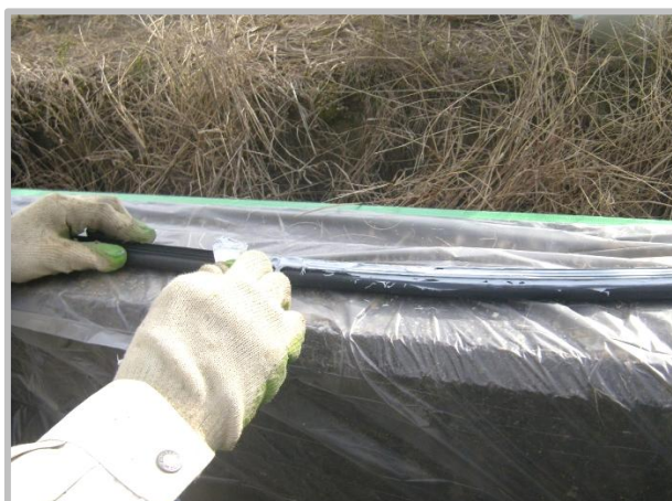
接着剤塗布工 (接着剤塗布状況)
