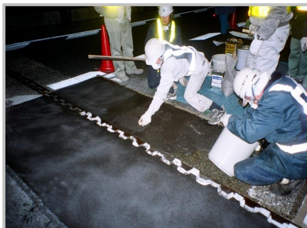
MMA樹脂モルタル打設
