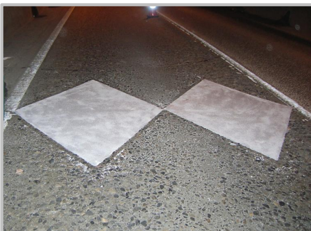
施工完了(薄層補修工法)
