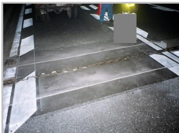
施工完了(橋梁伸縮装置嵩上げ工法)
