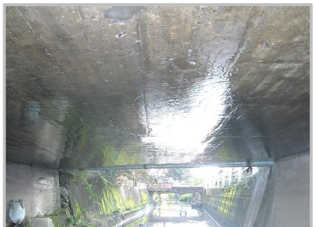
⑥ 施工完了
