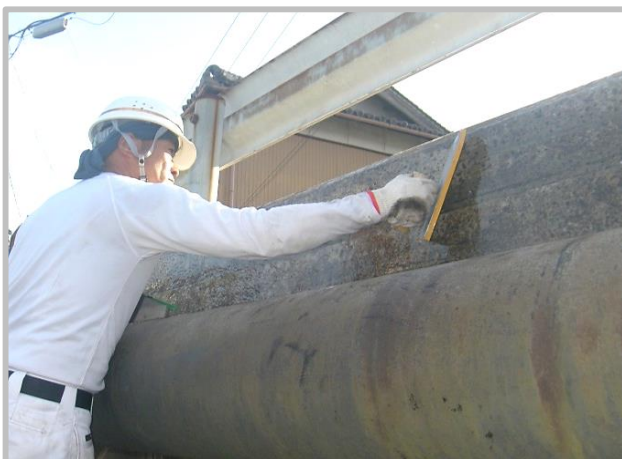
⑤ 表面被覆工(地覆)
