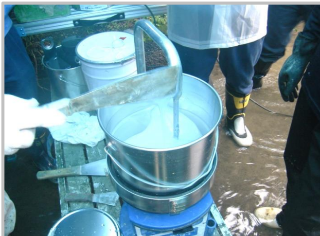
③ 材料攪拌状況
