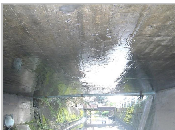
⑥ 施工完了
