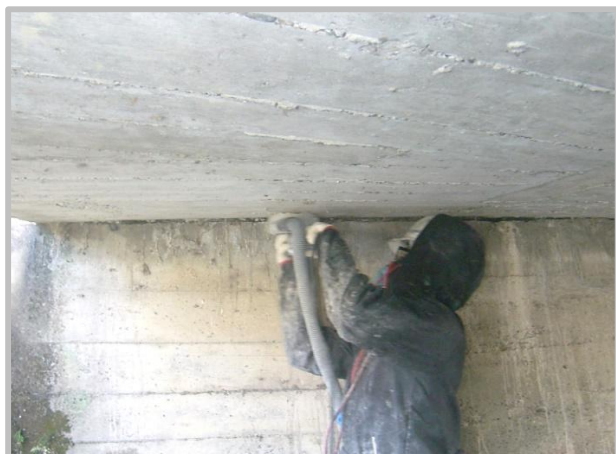
① 下地処理工(ケレン工)
