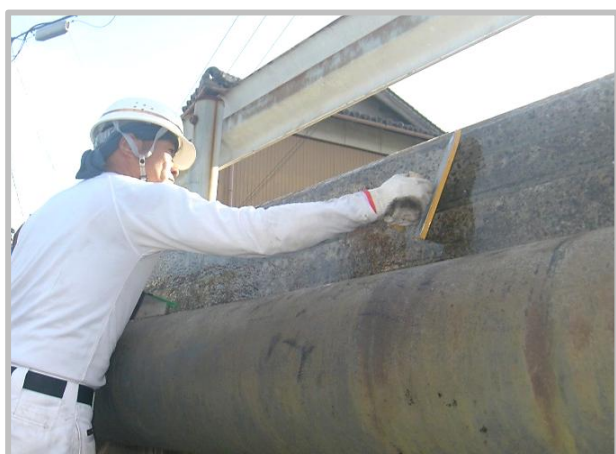
⑤ 表面被覆工(地覆)
