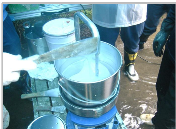
③ 材料攪拌状況
