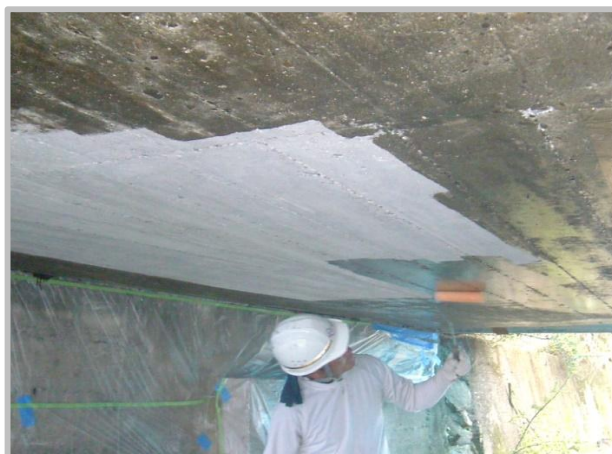
② プライマー塗布工
