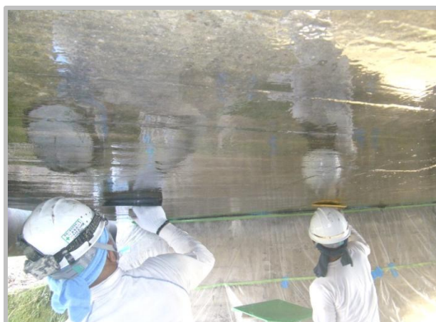
④ 表面被覆工(床版下面)
